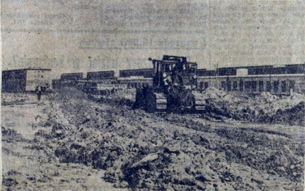
Spychacze na terenie nowej budowy.
