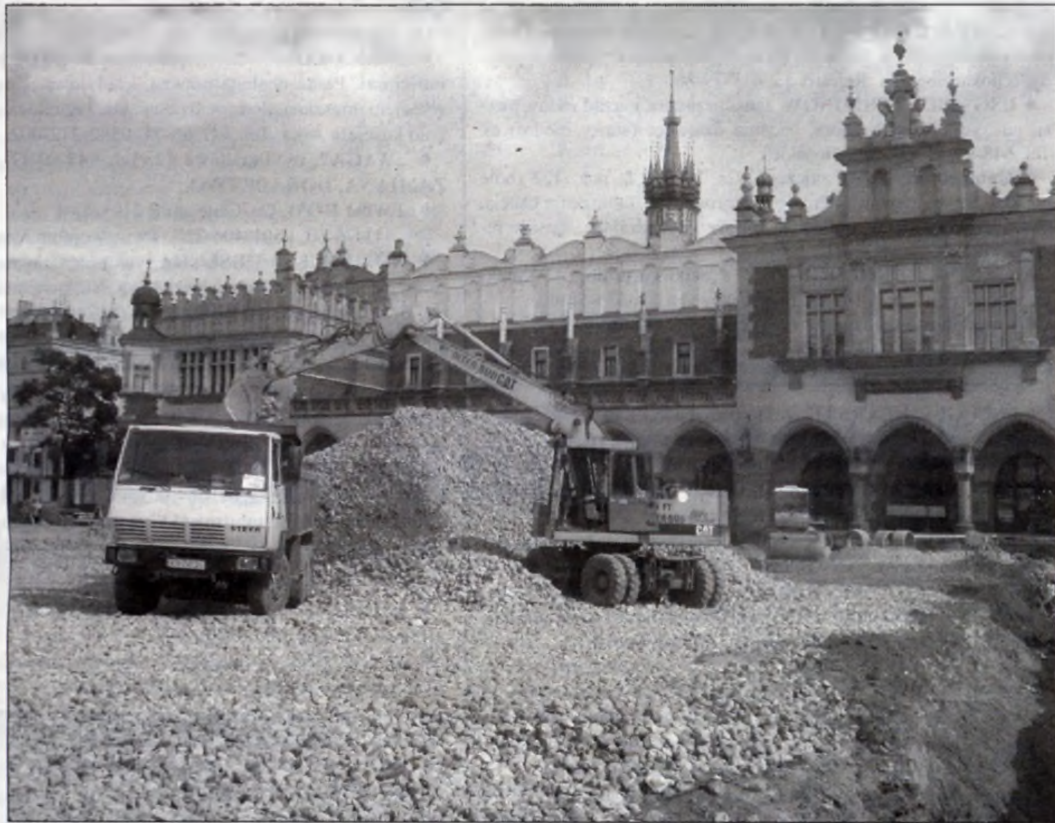
Trwa remont Rynku Głównego. Do stabilizacji jego płyty zostanie użyte kruszywo firmy Słag Recycling.
