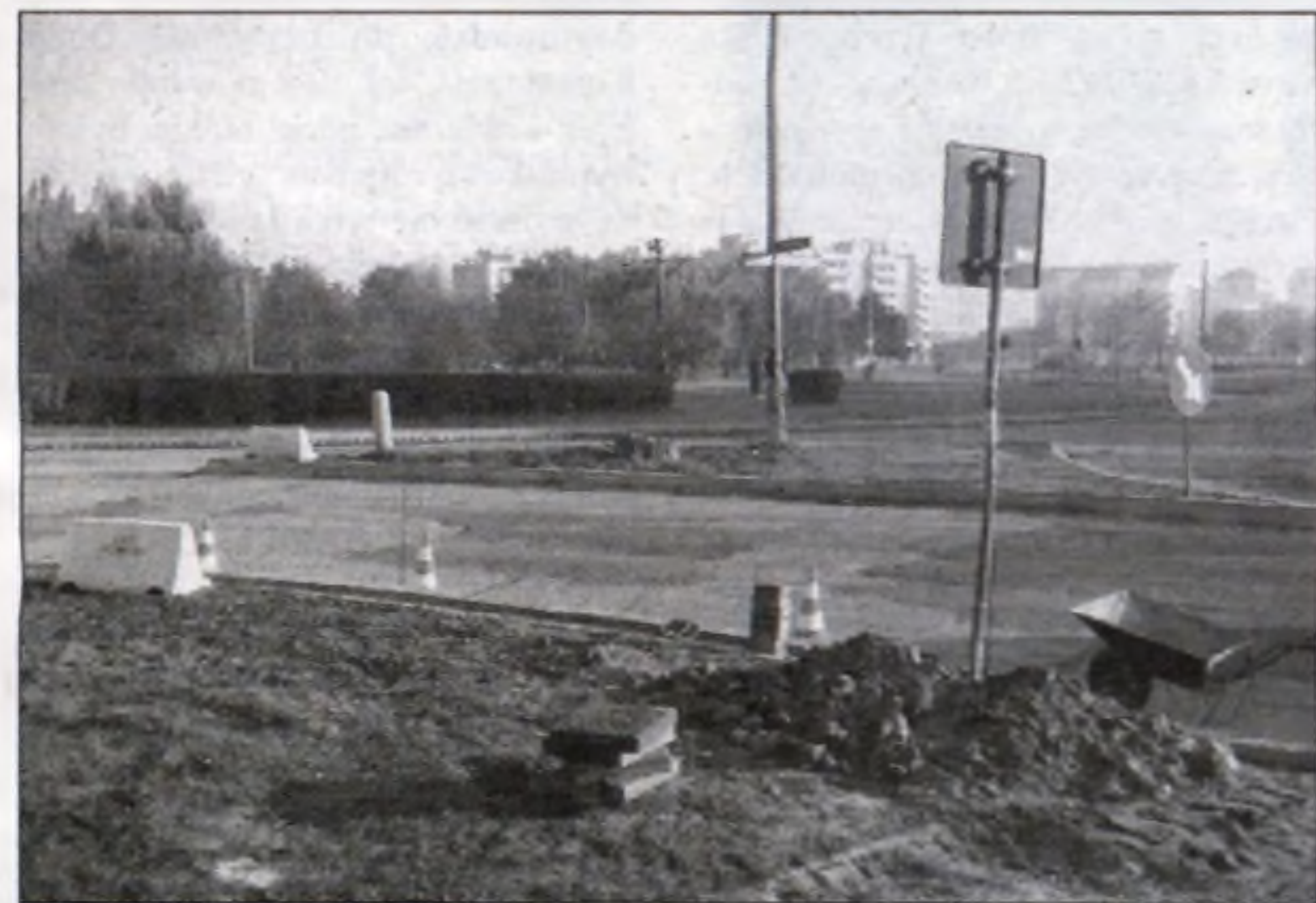
Wymiana nawierzchni asfaltowej ronda.
