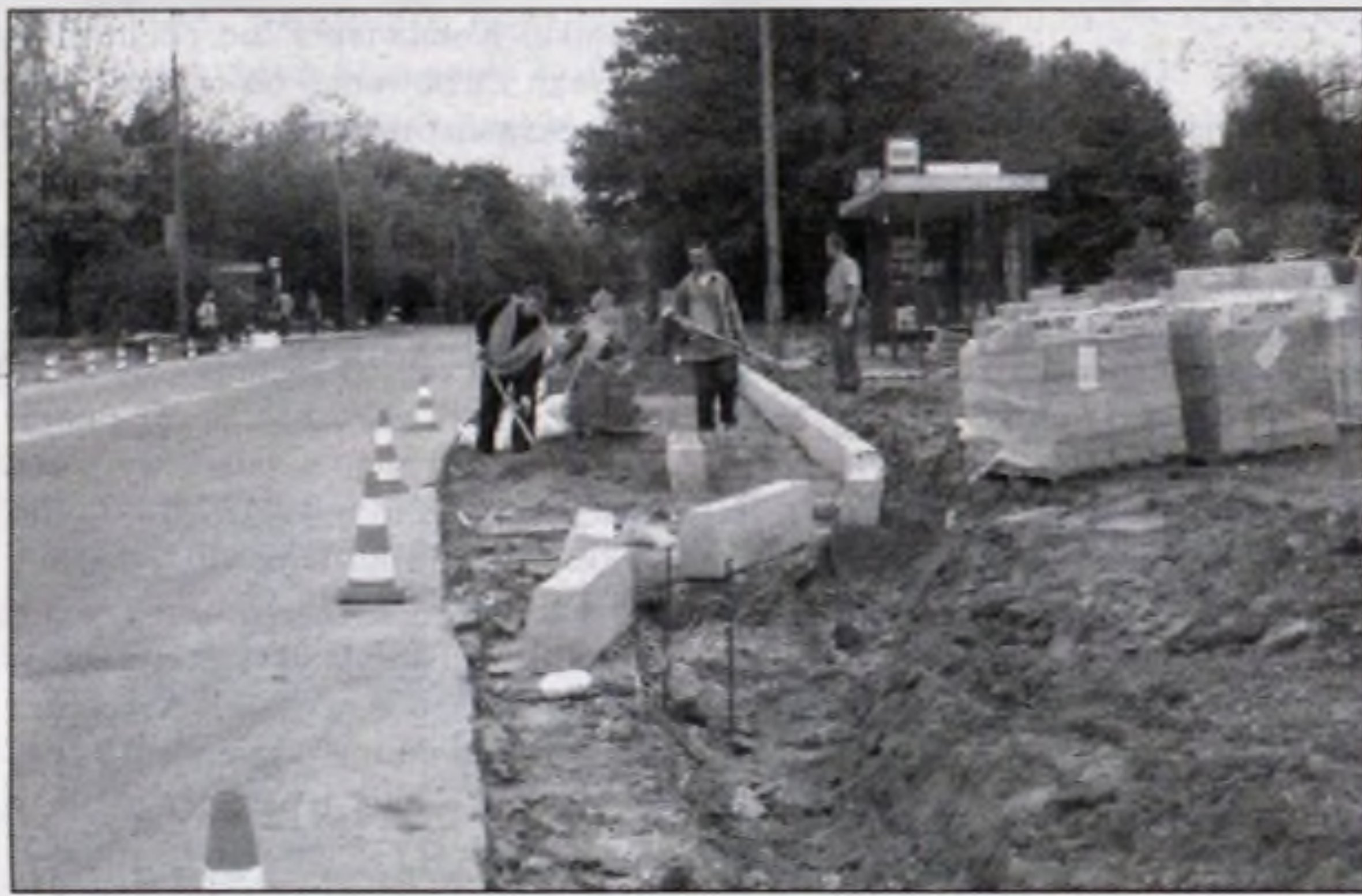
Prace przy zatoce autobusowej.
