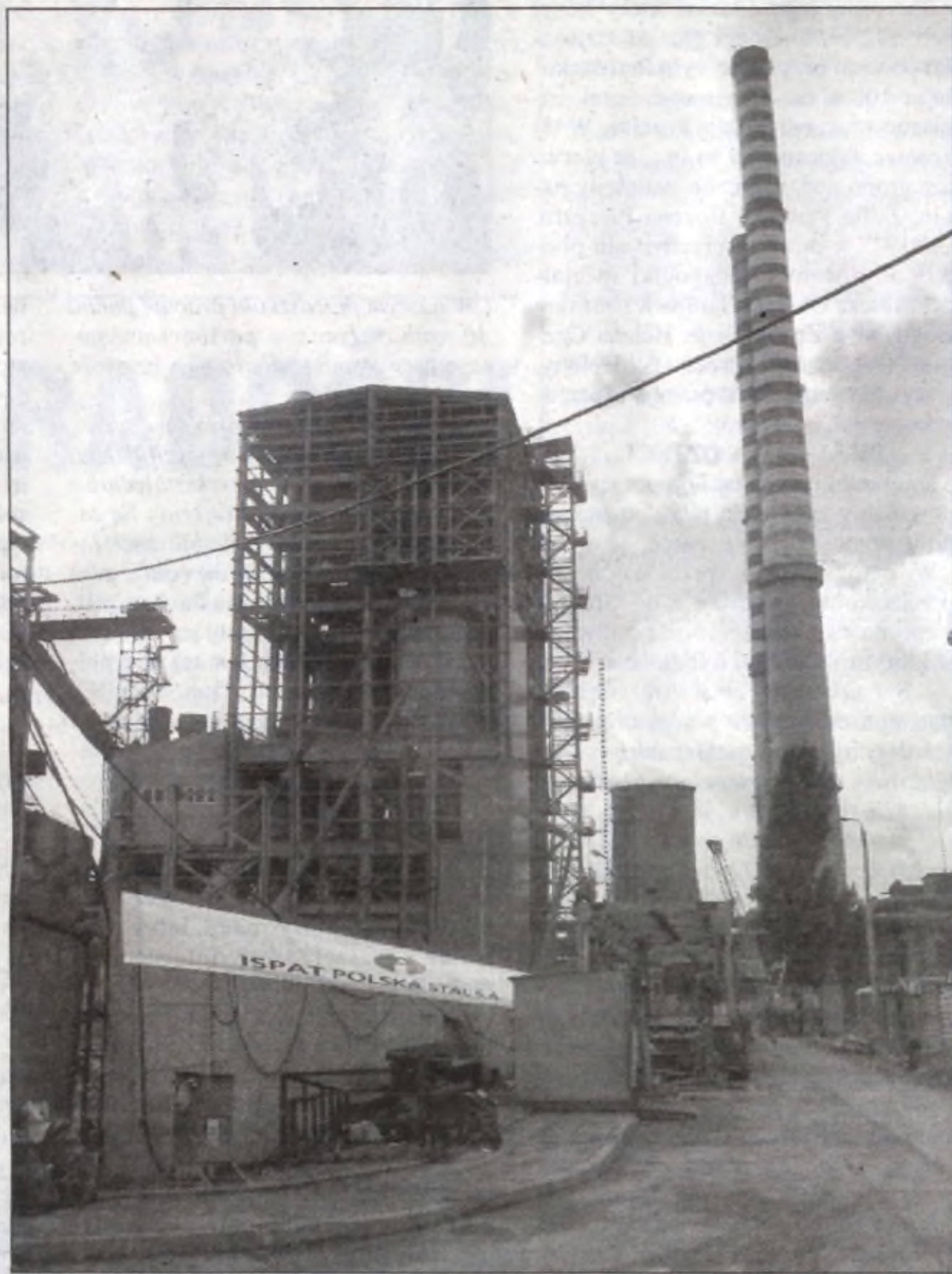
W maju br. podjęto ważną dla wydziałów surowcowych krakowskiego oddziału IPS decyzję - wznowienia inwestycji wdmuchiwanie pyłu węglowego do wielkich pieców. Jej realizacja pozwoli na obniżenie kosztów produkcji surowki, gdyż koks zostanie częściowo zastąpiony pyłem węglowym, który jest tańszy.
