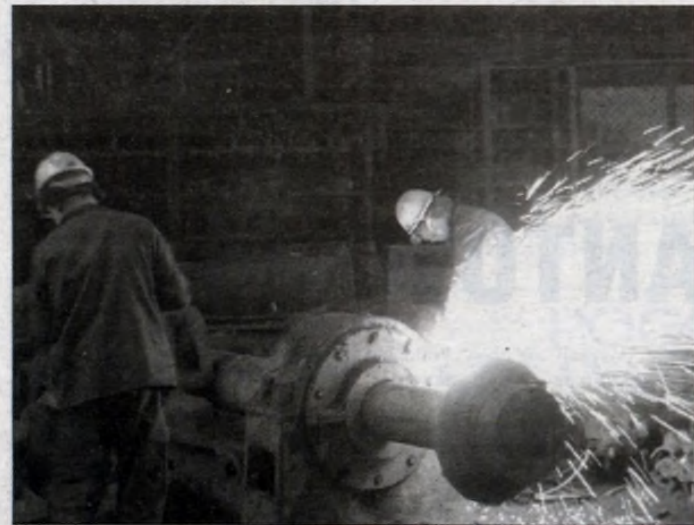
...na razie trwa demontaż urządzeń.
