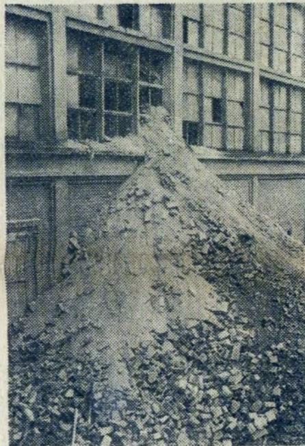
Wysoka sterta gruzu szpecąca główny obiekt Dolomitowni.
