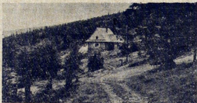
Schronisko turystyczne PTTK na Halę Krupowej.
