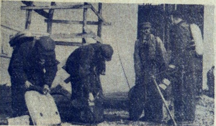
Prace przy rurociągu.
