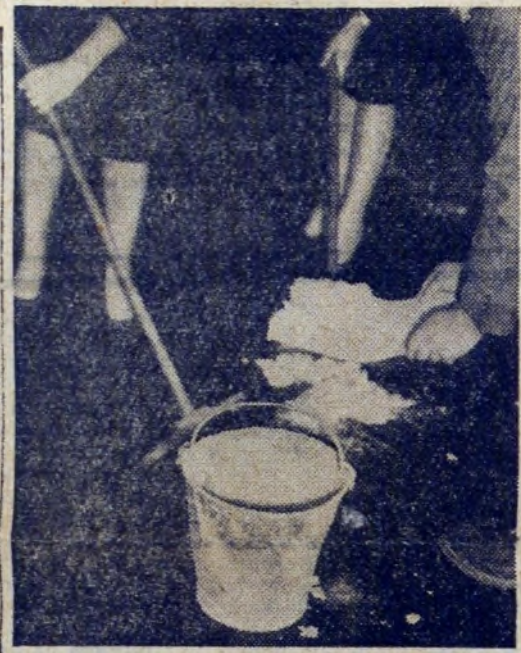
Niestety wykonanie budynku klubu pozostawia wiele do życzenia. Właśnie spadł tynk...
