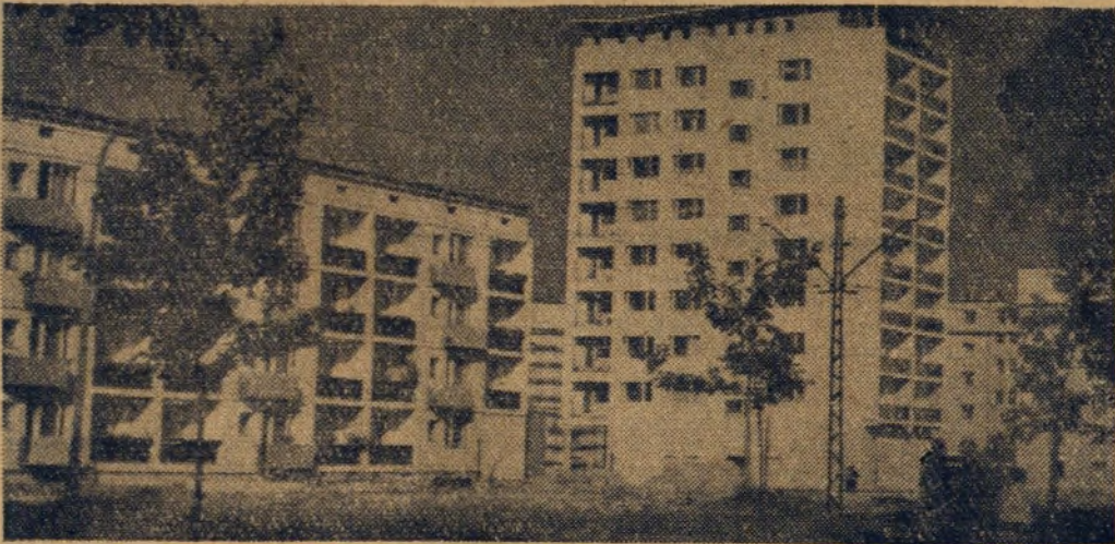
Blok 19 na osiedlu B-32. Jest to tzw. blok szwedzki według projektu inż. J. Ingardena. Kubatura: 76.165 m³. Posiada mieszkania 1, 2 i 4 pokojowe. W części C — parter usługowy.
