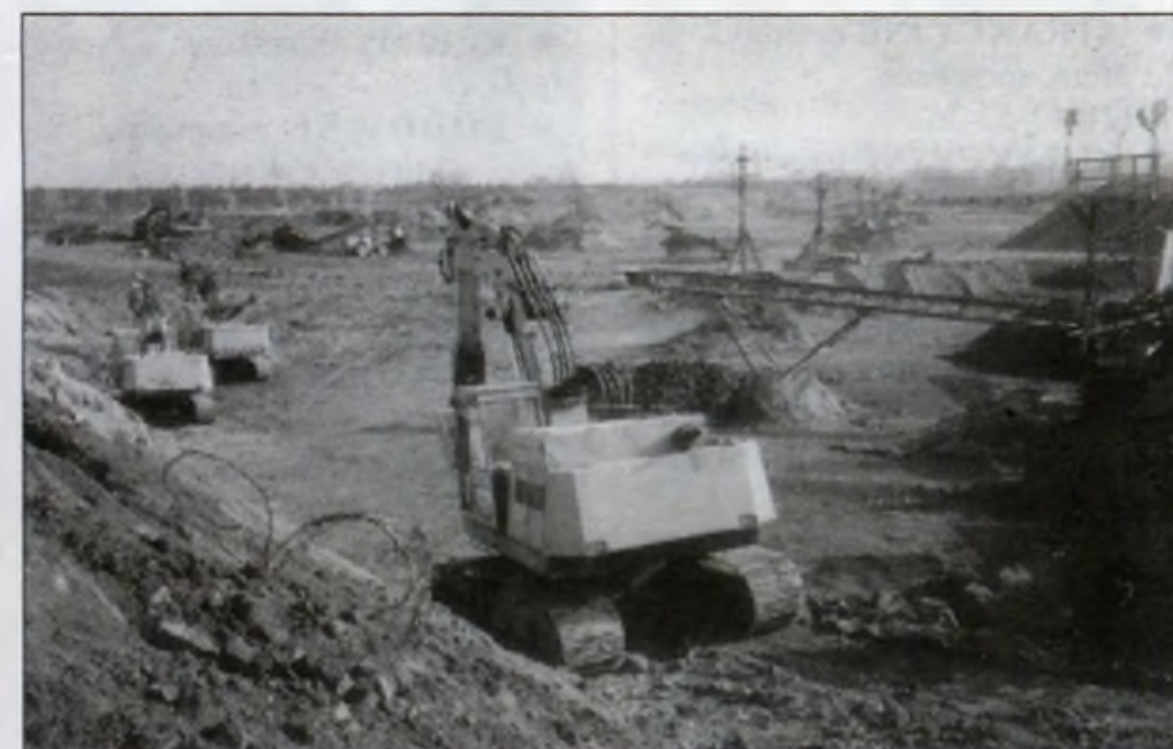
Za sprawą MADROHUTU znikła hałda śmieciowa w Ruszcy.
