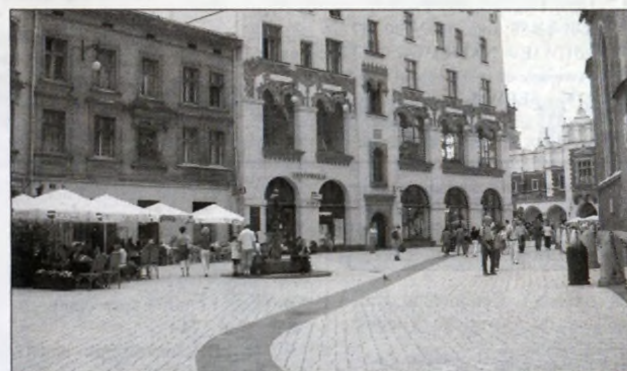
Kruszywo z pleszowskiej hałdy wyprodukowane przez Slag Recycling posłużyło m.in. do utwardzenia Placu Mariackiego w Krakowie, utwardziło podbudowę Rynku Krakowskiego oraz było wykorzystane przy remoncie modernizacyjnym drogi Kraków – Targowisko
