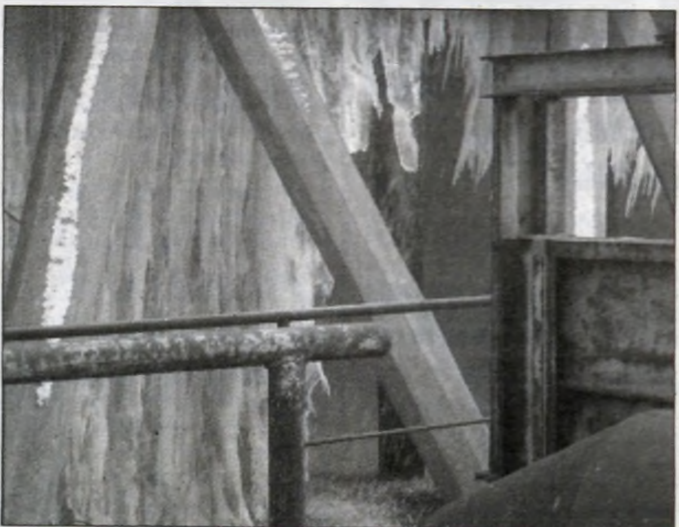
Najwięcej, ba cały „fartuszek” lodowych sopli znaleźliśmy u wlotu chłodni kominowej w okolicach wielkich pieców. Na zewnątrz panował 14-stopniowy mróz.
