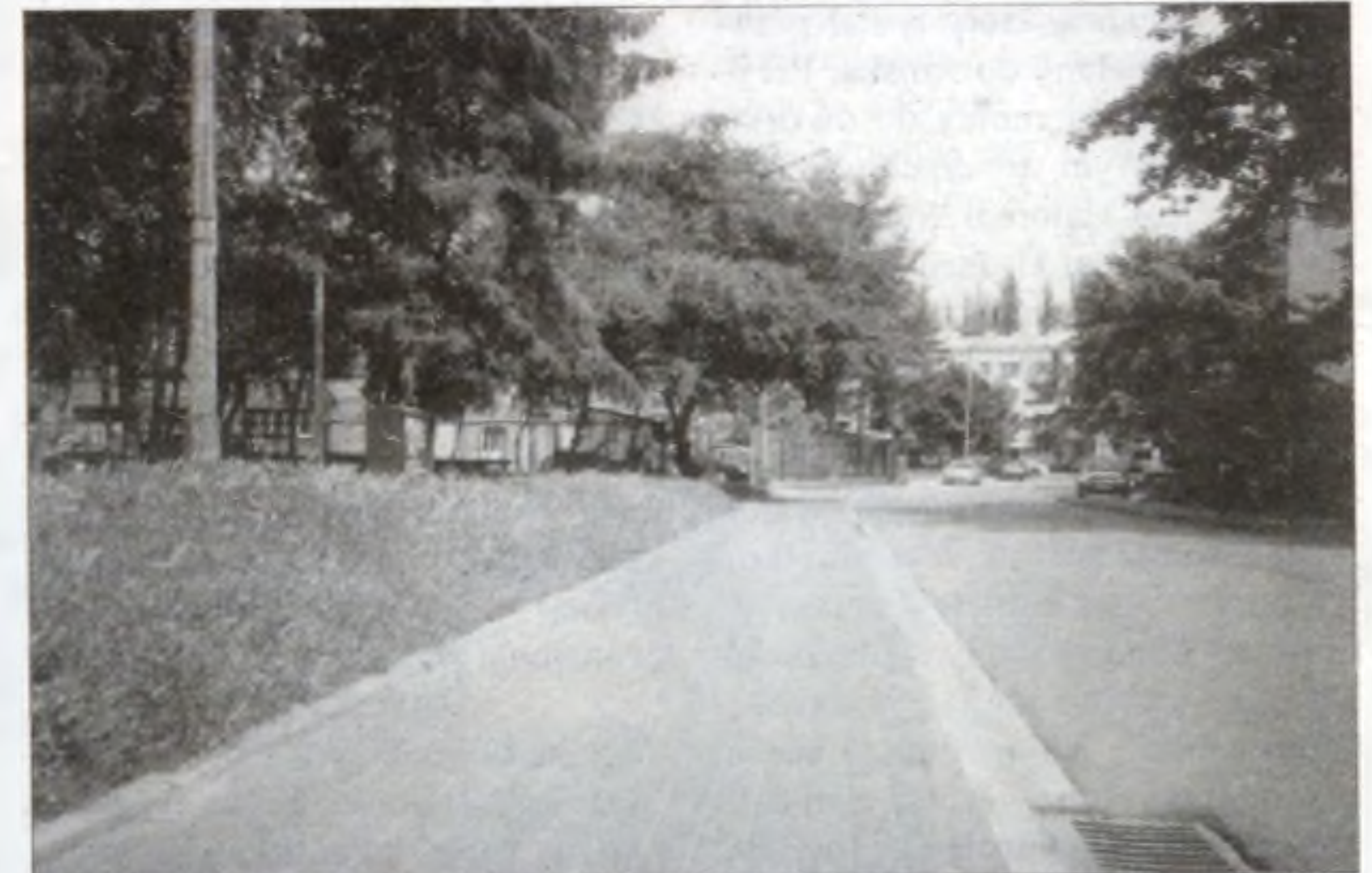
Nowy chodnik – od poczty do bloku nr 17a – na os. Kolorowym.
