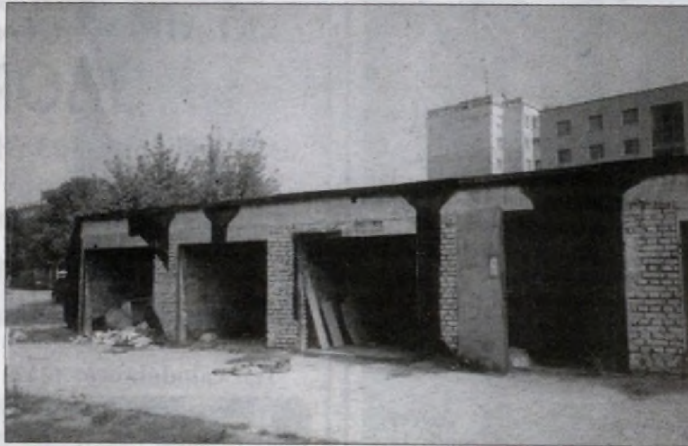
Jeszcze niedawno przy placu Centralnym, pomiędzy Nowohuckim Centrum Kultury i os. Centrum E stały takie „garaże”.
