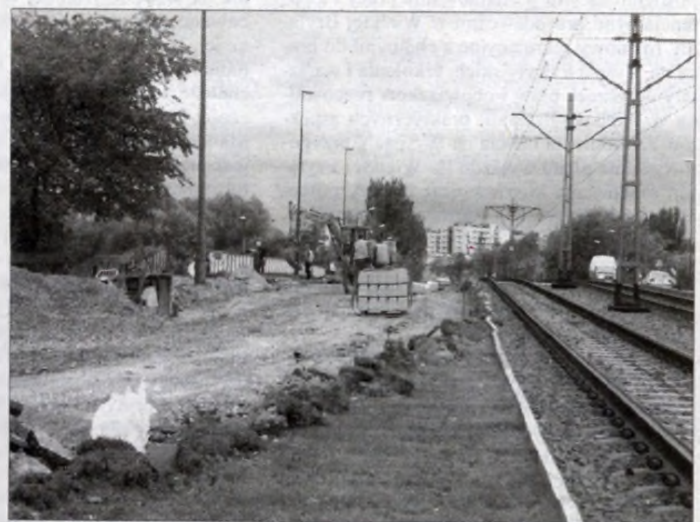
Remont wschodniej strony wiaduktu
