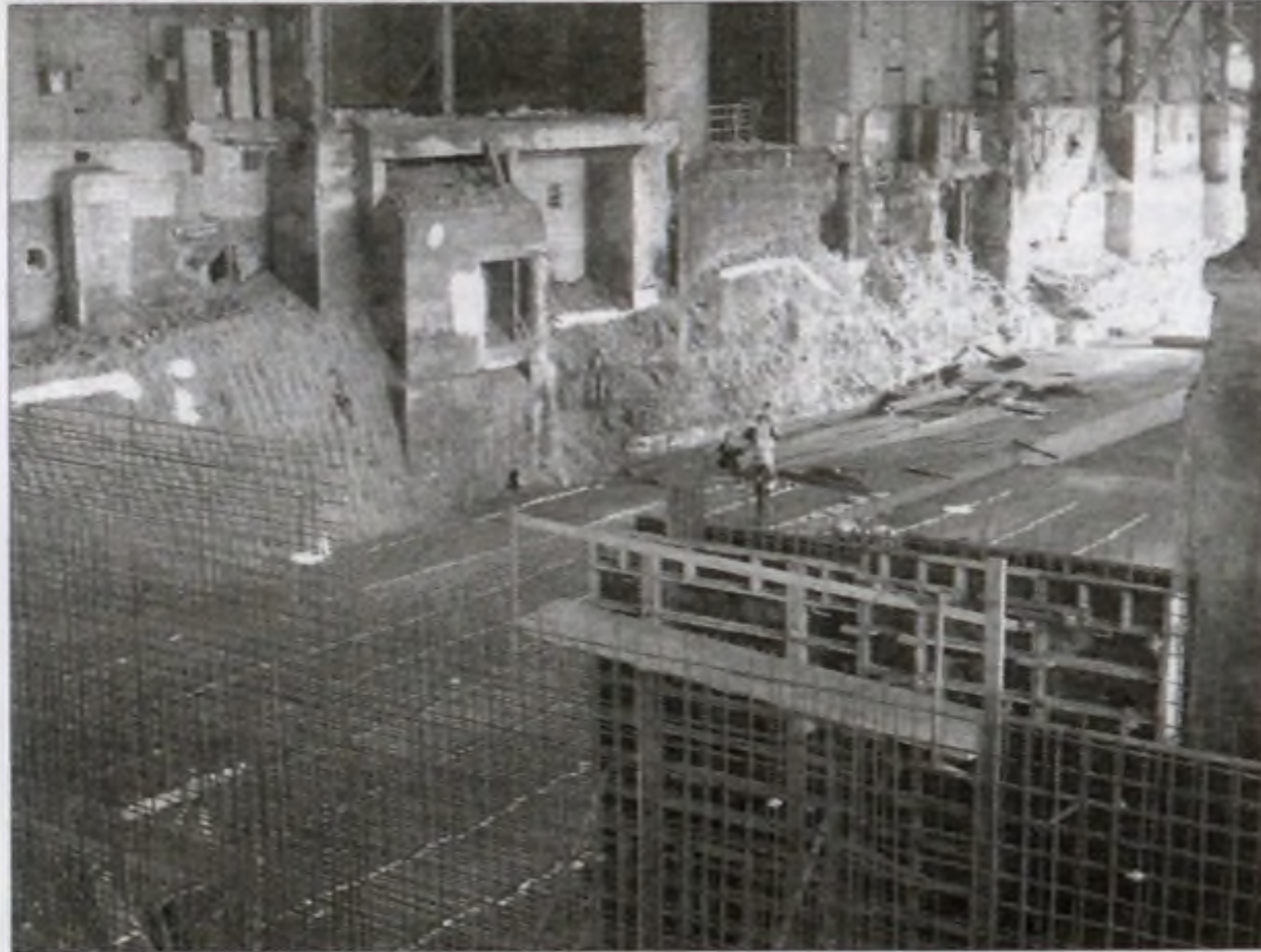
Plac wielkiej budowy – dawna hala slabinga.
