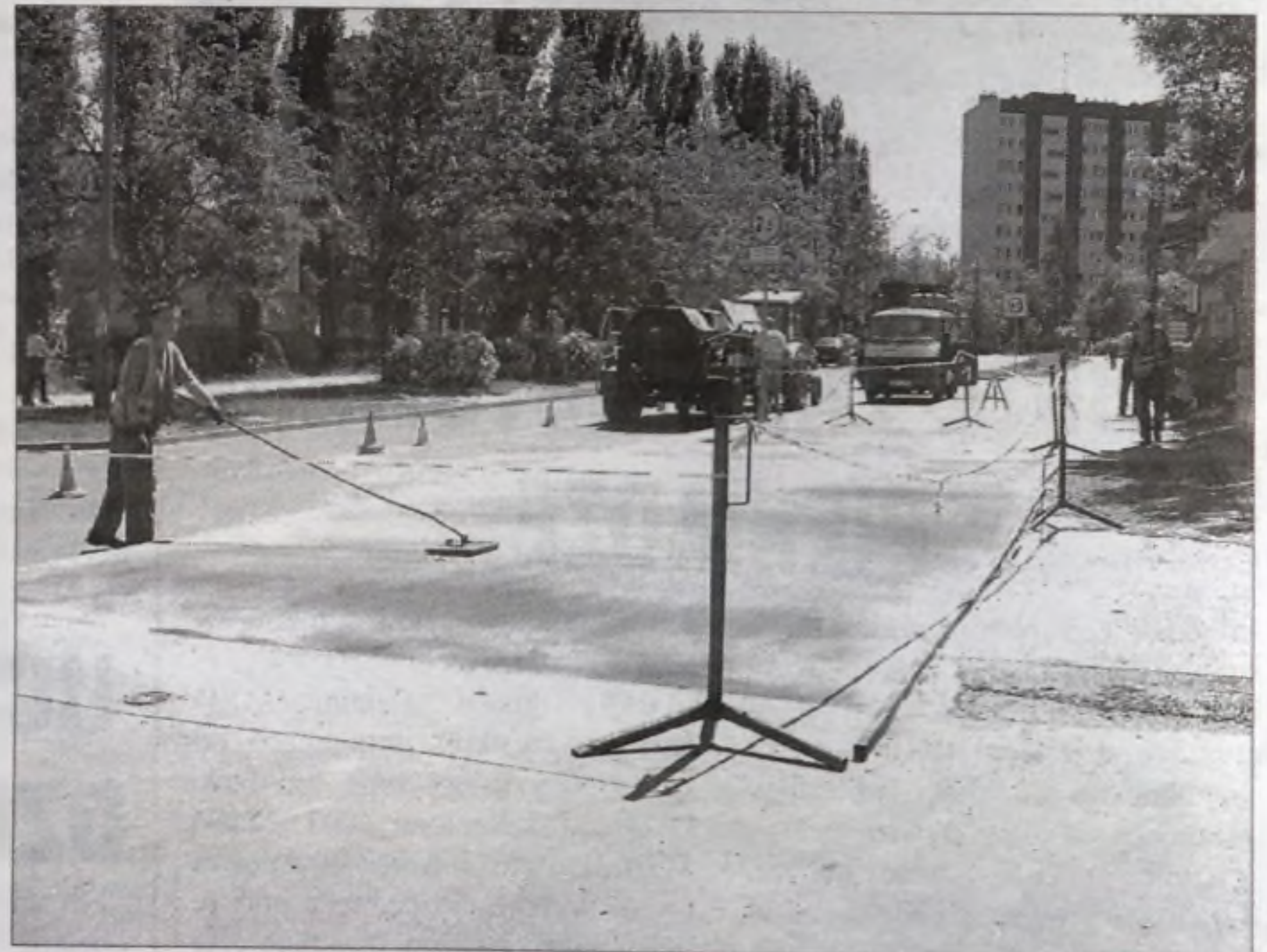
Prace wykończeniowe przy ul. Miśnieńskiej.
