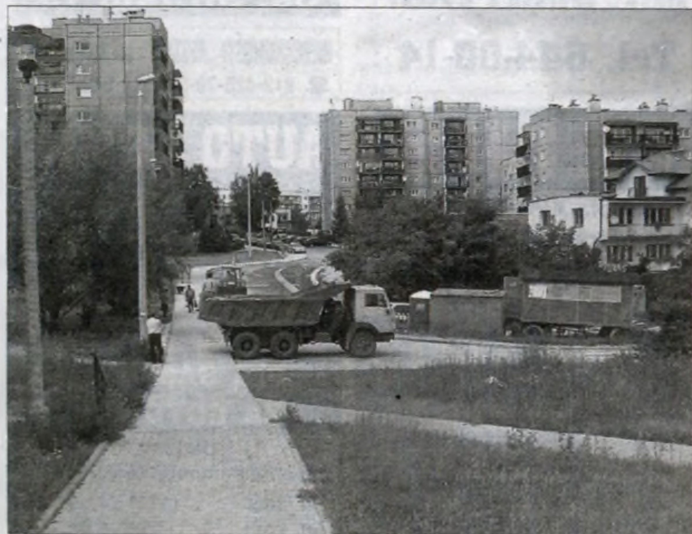
Ostatnie prace porządkowe.
