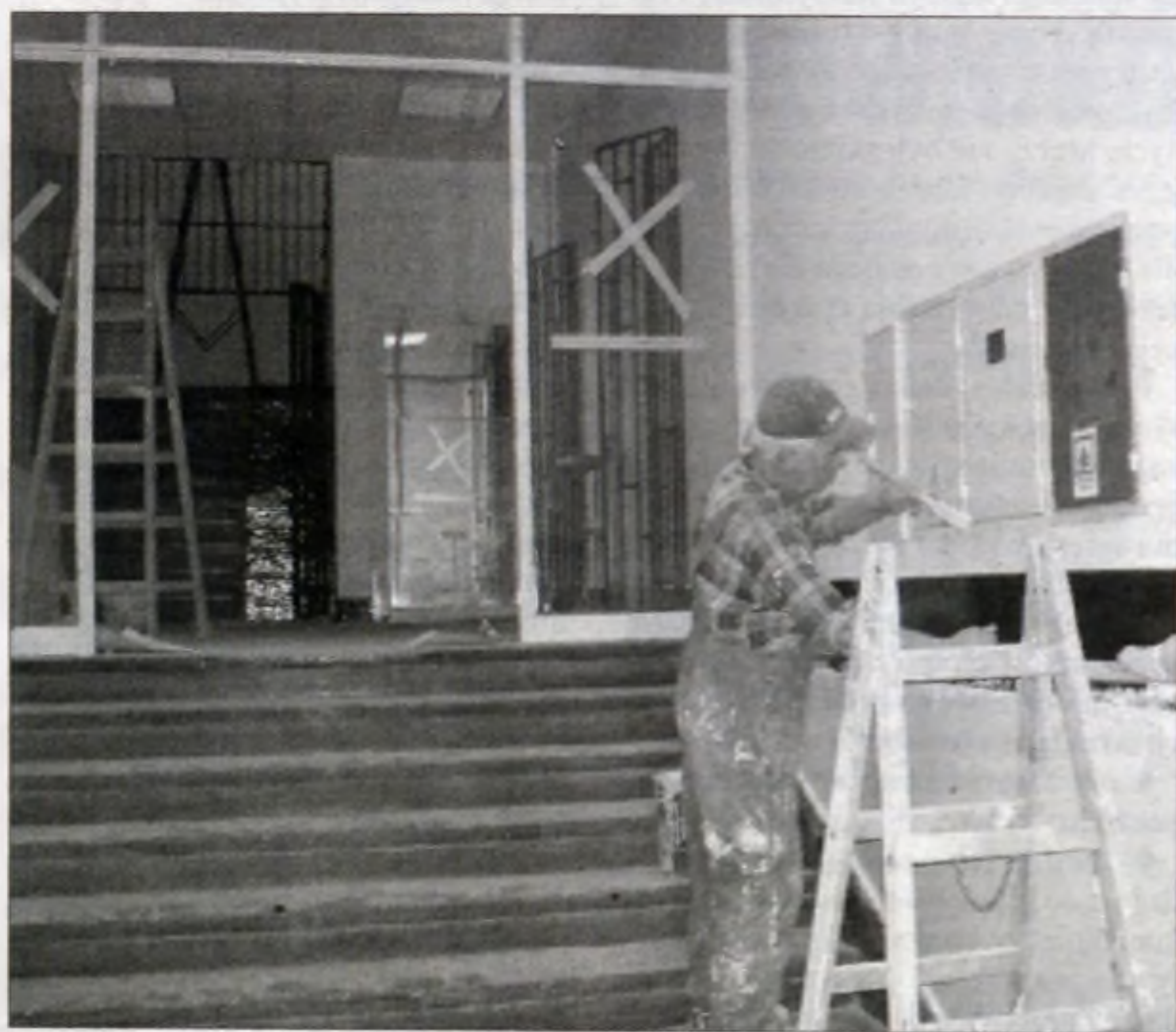
Pomieszczenia MOWIS znajdujące się w budynku NOT zostały dokładnie wyremontowane. Na zdjęciu – ostatnie prace kosmetyczne.
