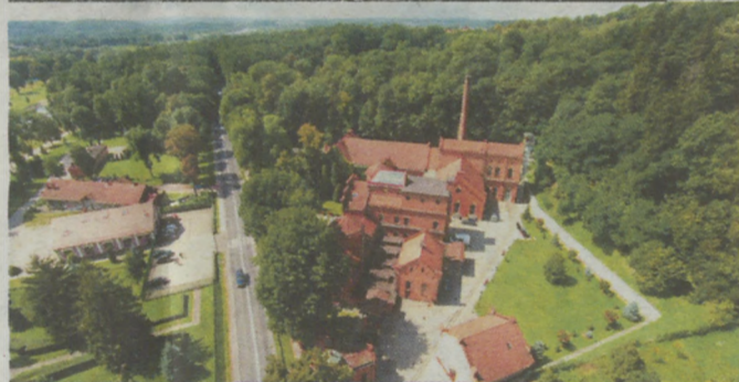
Zakład Uzdatniania Wody Bielany – dawniej i dziś
