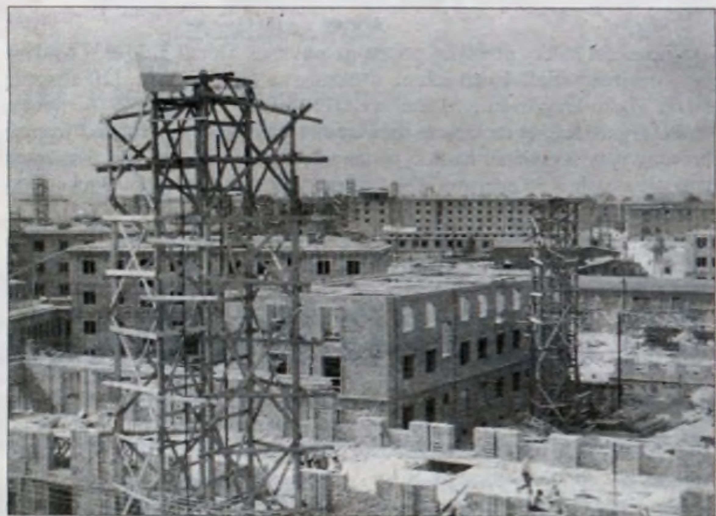
Budowa domów mieszkalnych w centralnych osiedlach Nowej Huty, 1953 r.
