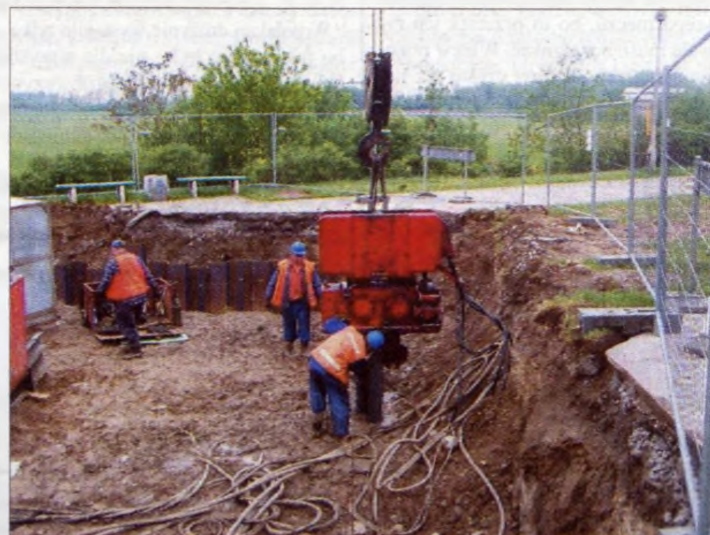
Prace zostały rozpoczęte.
