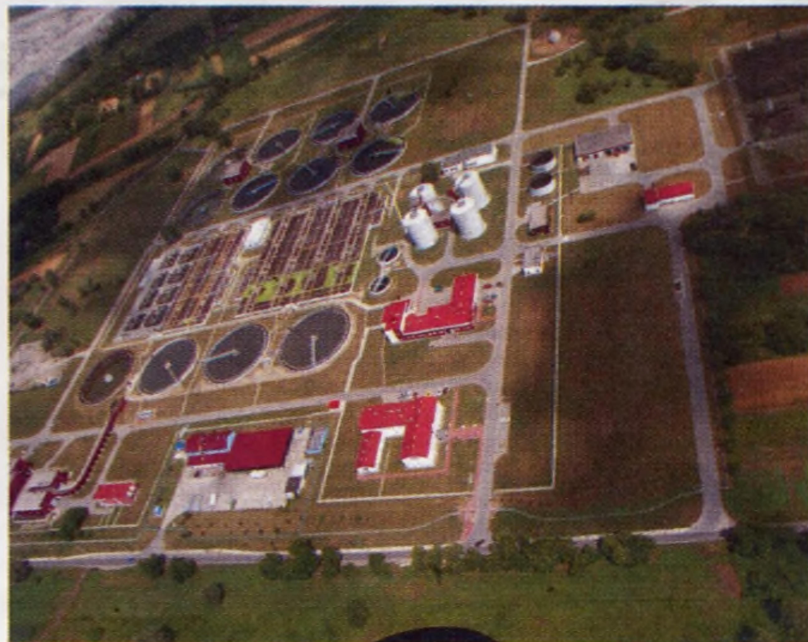
Oczyszczalnia „Kujawy” czeka na ścieki z nowo budowanej kanalizacji.
