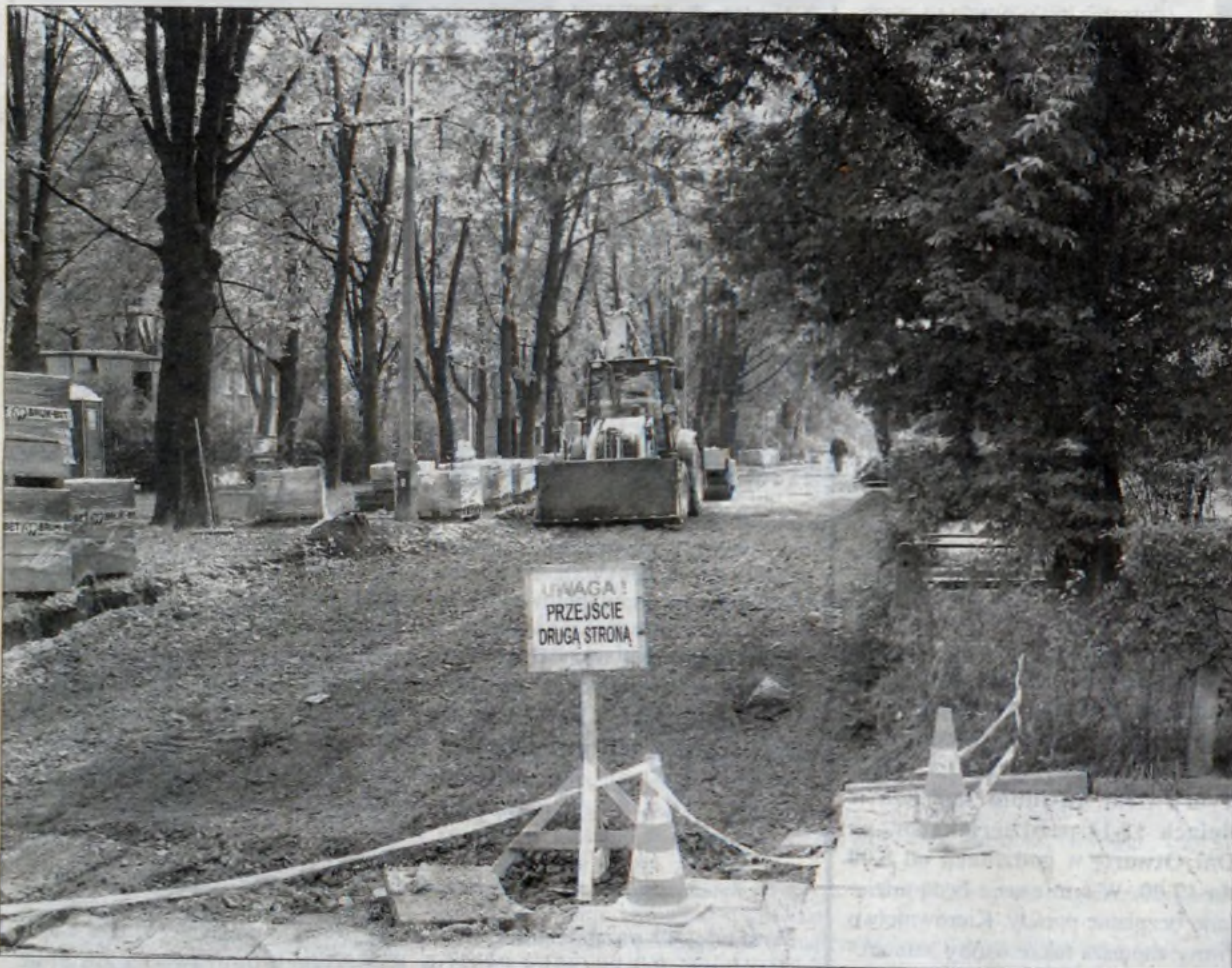
Budowa chodnika przy ul. Wojciechowskiego od strony os. Zielonego.
