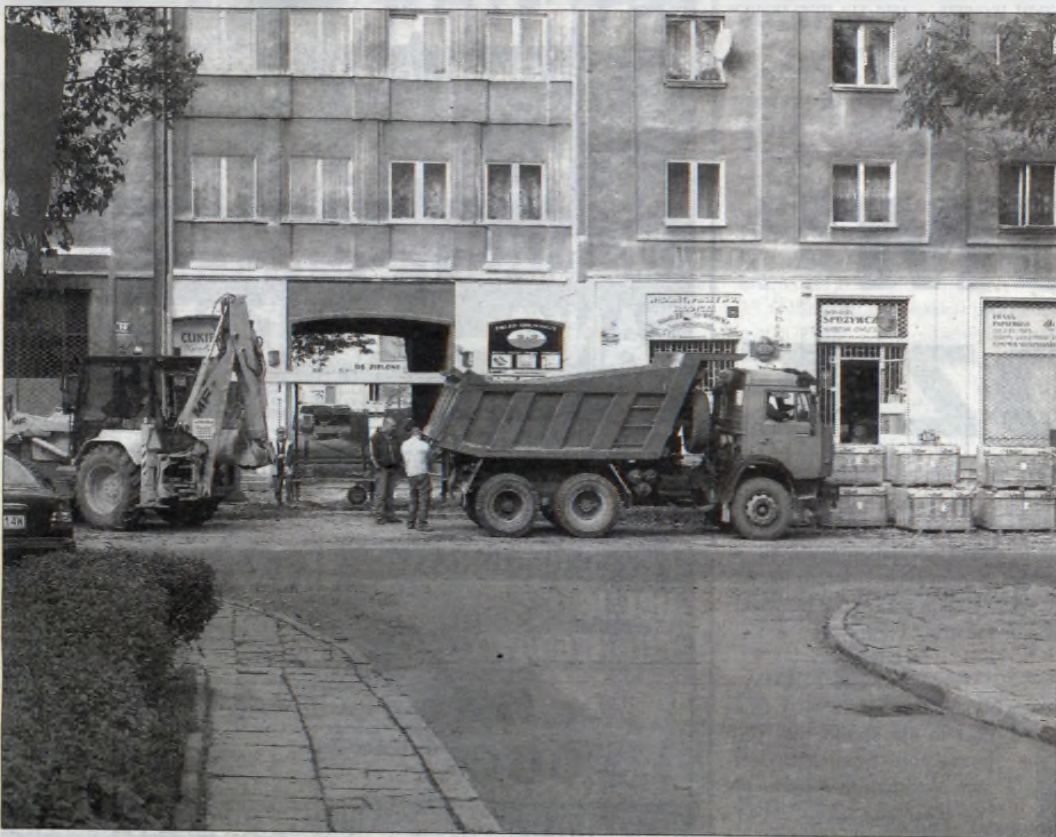
Budowa chodnika przy ul. A. Struga od strony os. Szklane Domy.
