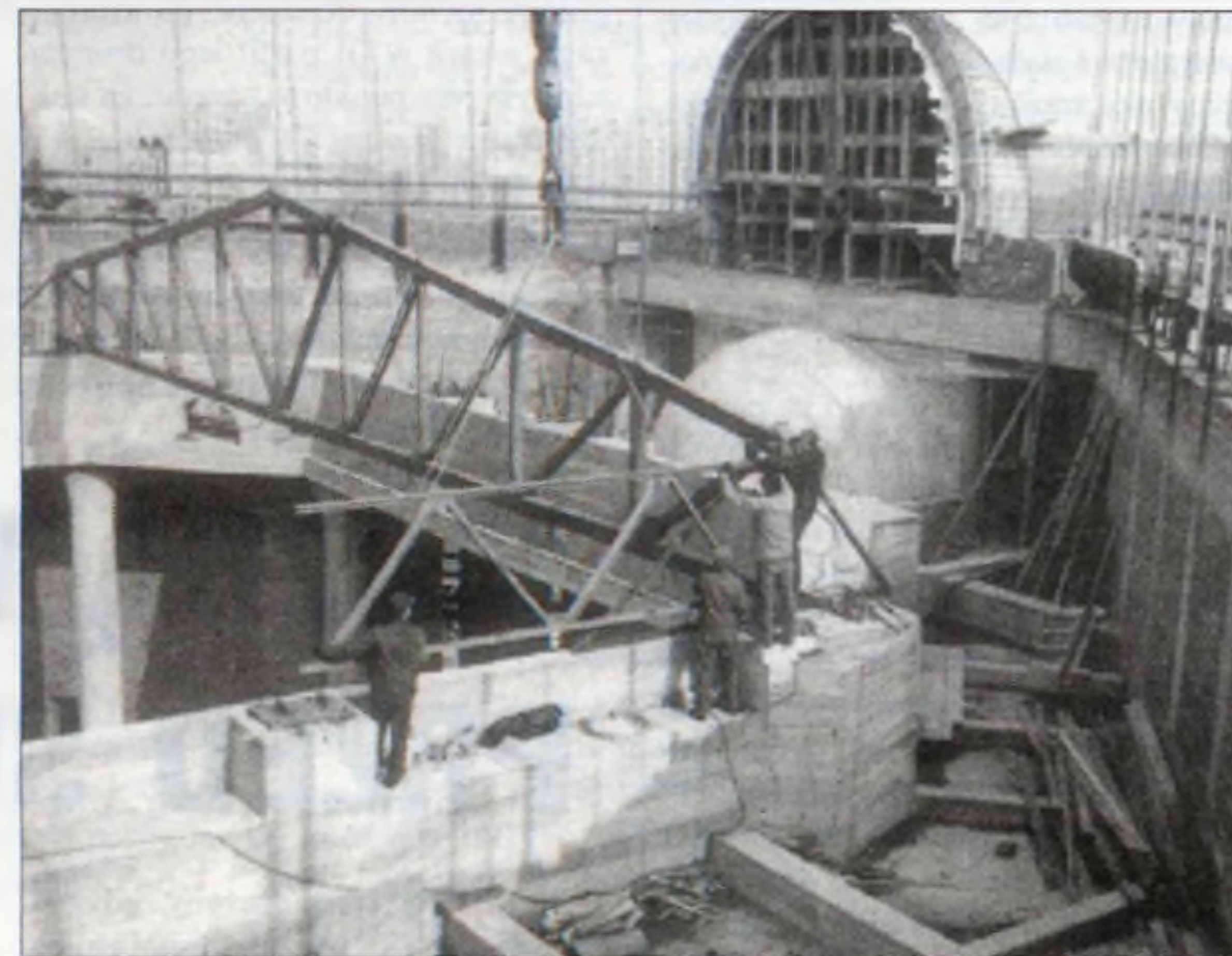
Budowa kościoła na os. Dywizjonu 303.
