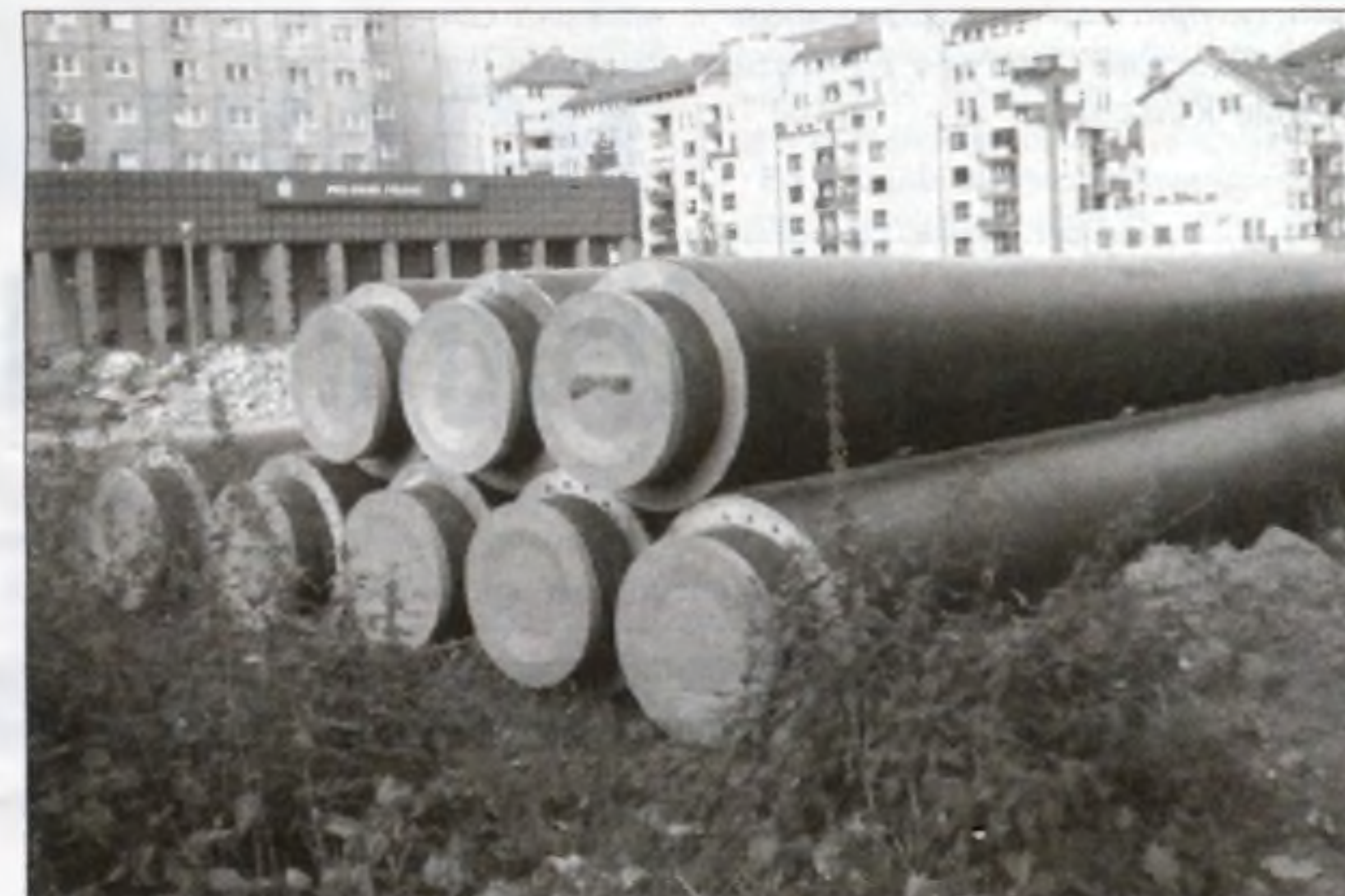
Rury preizolowane są niezawodne w transporcie energii cieplnej.
