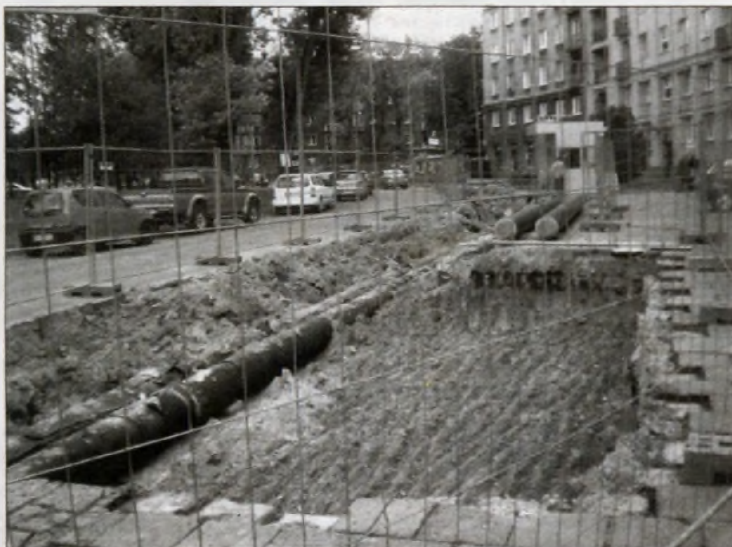
Ostatni odcinek robót – os. Handlowe, obrzeże Centrum C do os. Zgody.
