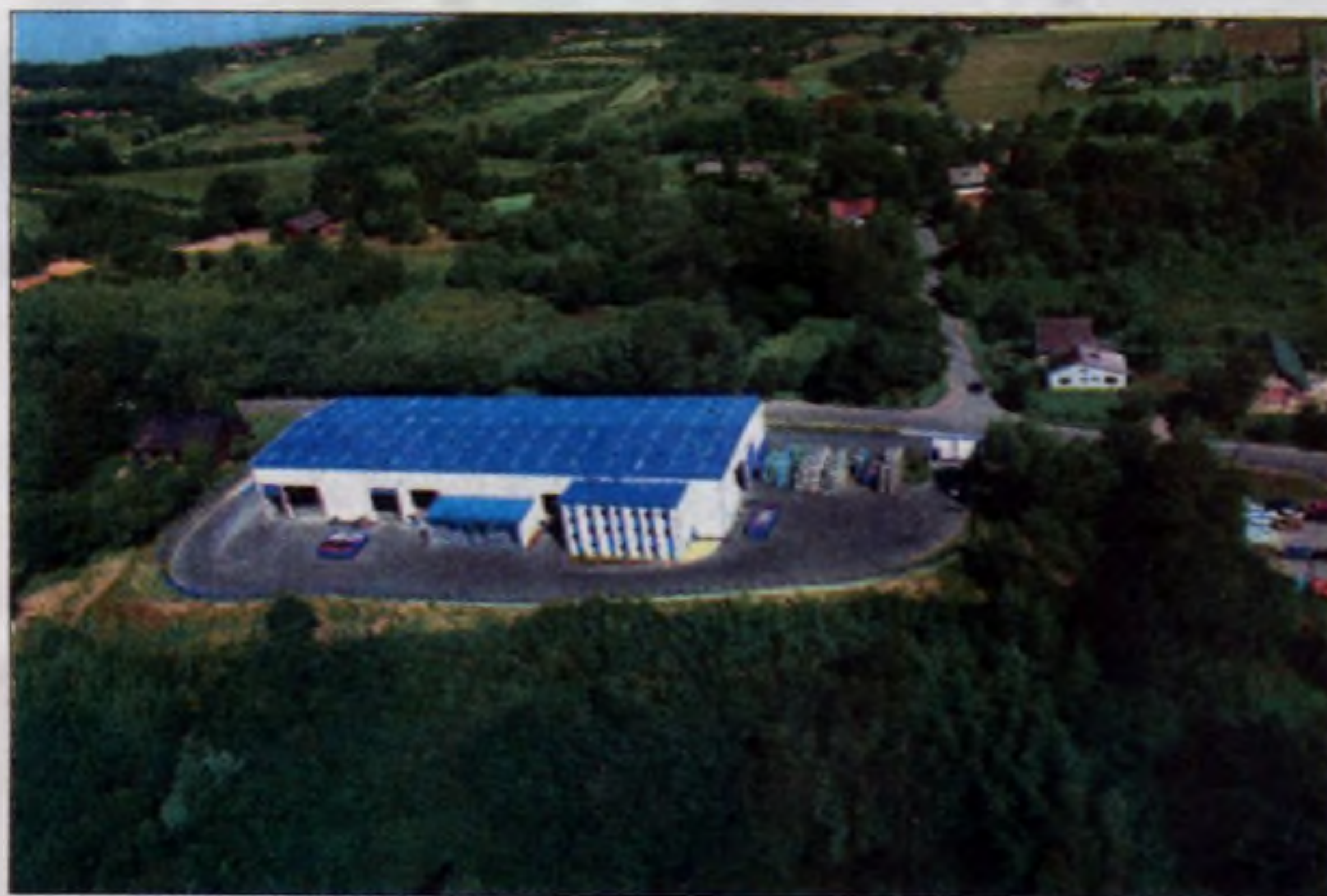
Obiekt nowoczesnej sortowni na Baryczy.
