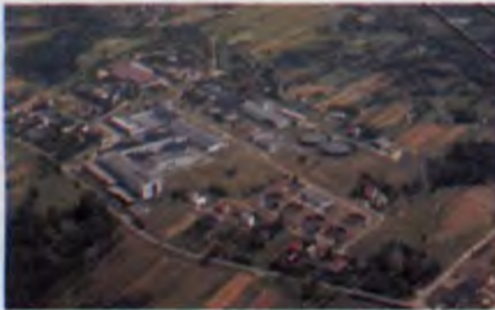
Zakład Uzdatniania Wody RABA
