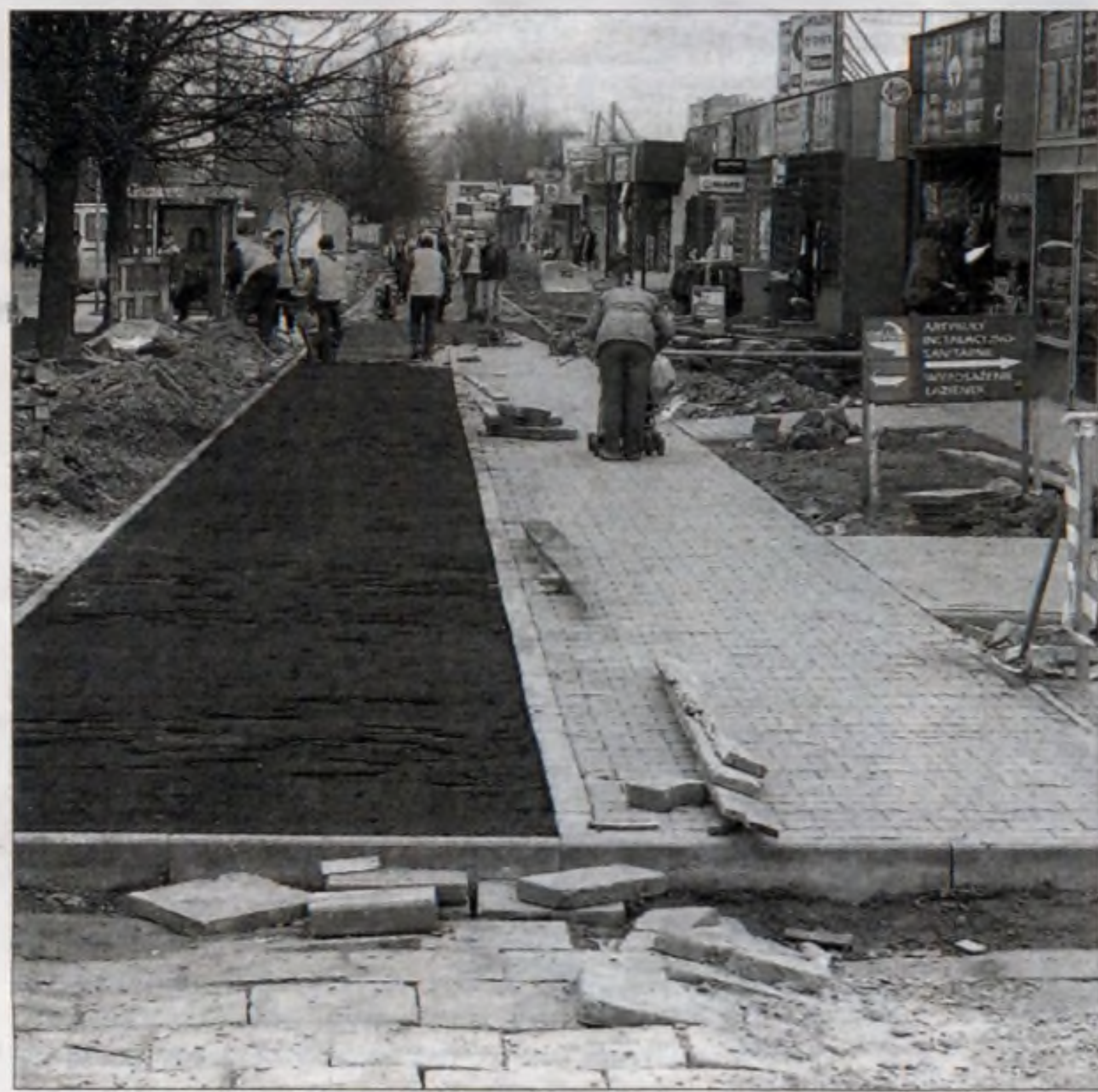
Wzdłuż alei gen. Andersa powstaje nowy chodnik i ścieżka rowerowa.
