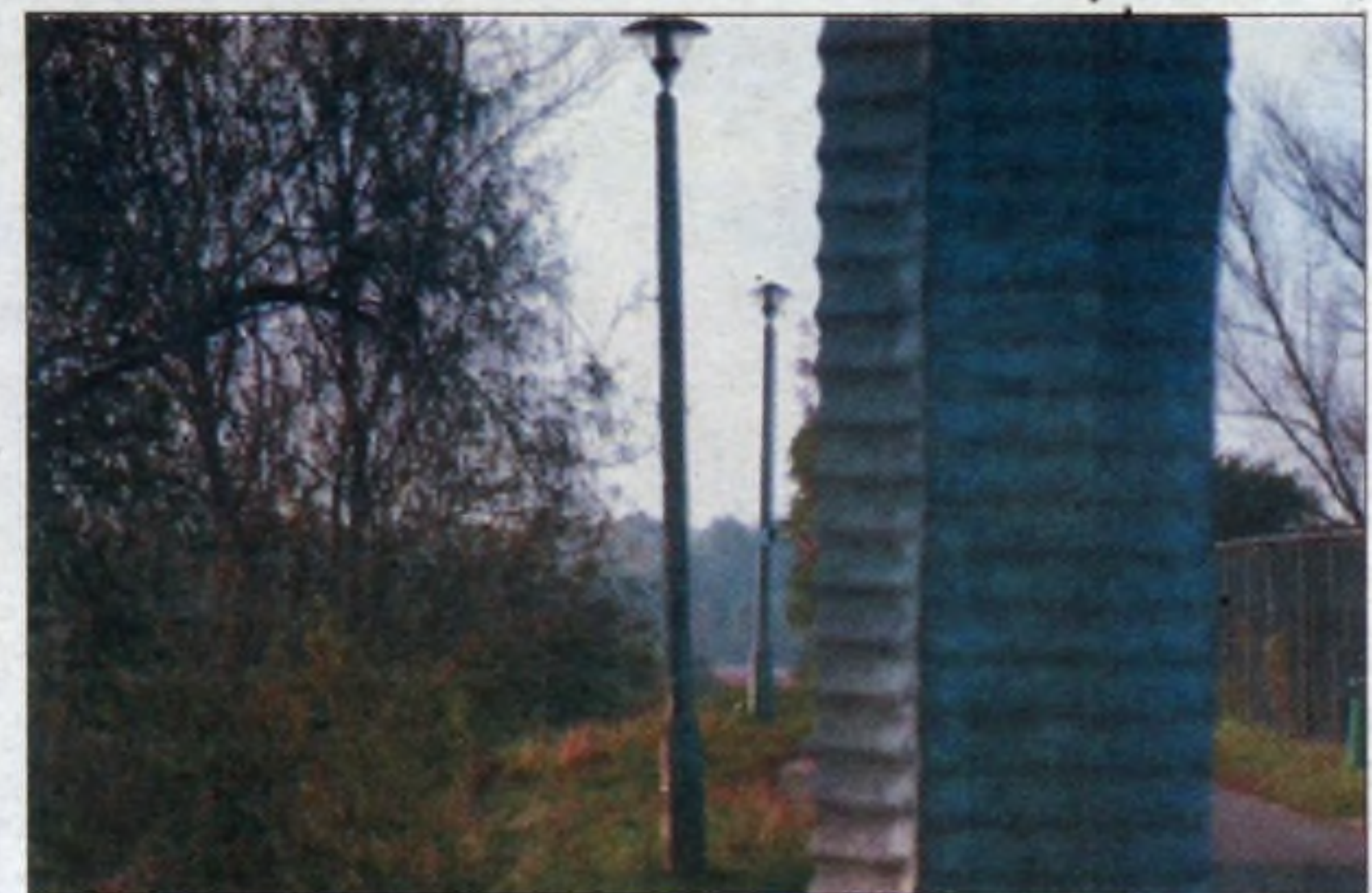
Słupy oświetleniowe na brzegu skarpy przechylają się.
