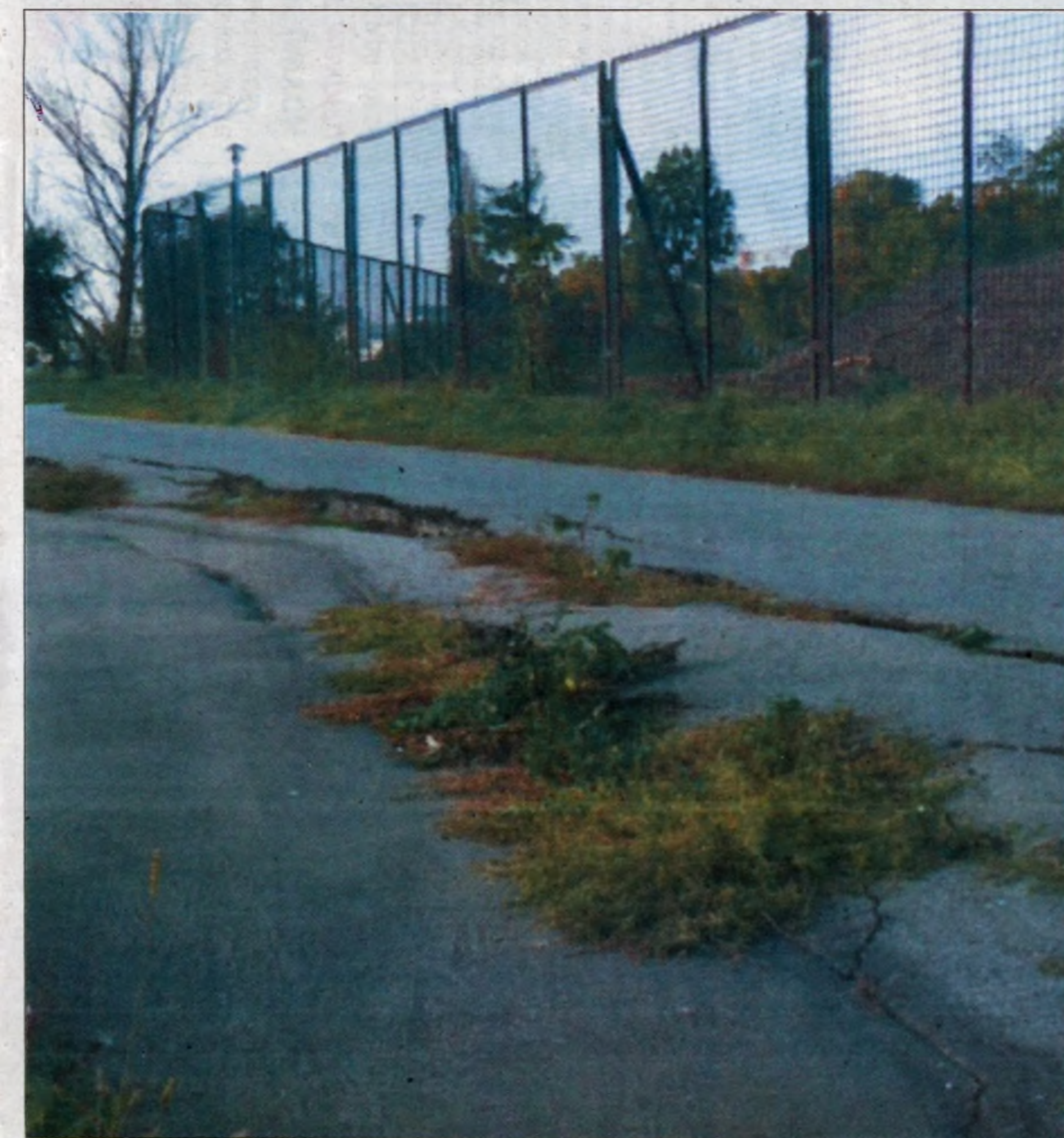
Asfaltowa alejka nad brzegiem skarpy pomimo bieżących napraw nadal pęka.
