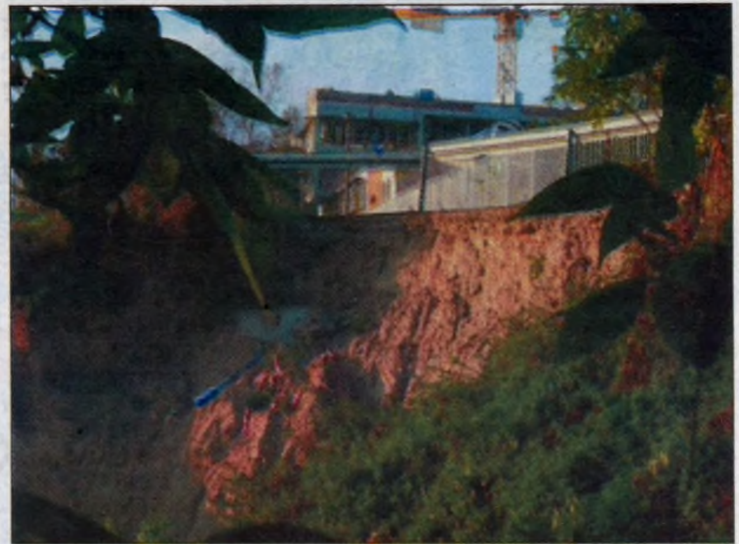
Urwisko w pobliżu budowanych obiektów szkoły muzycznej.
