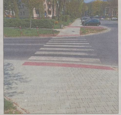
Przejście dla pieszych: ul. Jagielly/ul. Poległych w Krzesławicach.
