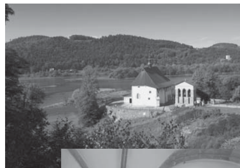
Widok na kościół w Tropiu.
