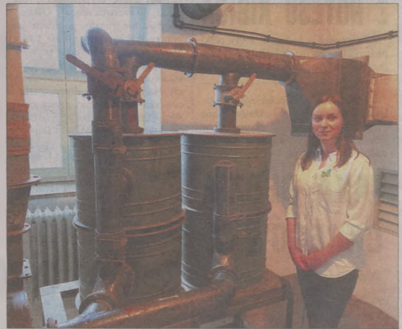
Instalacja oczyszczania powietrza w schronie.
