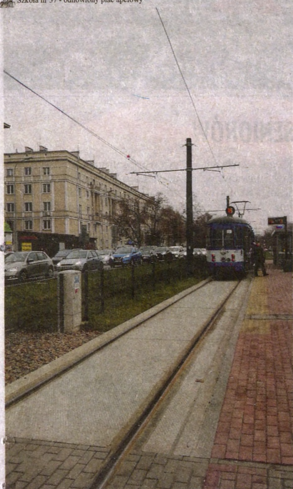
Fot. nowe torowisko ul. Ptaszyckiego
