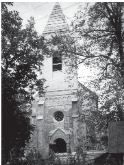
Kościół w Skolem w odbudowie, 1995
