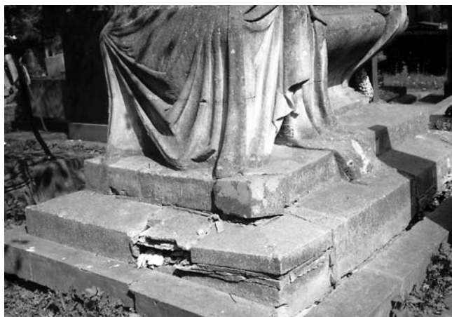
Symboliczny sarkofag Cmentarzyka Żelaznej Kompanii – widoczne zniszczenia kamieniarki
