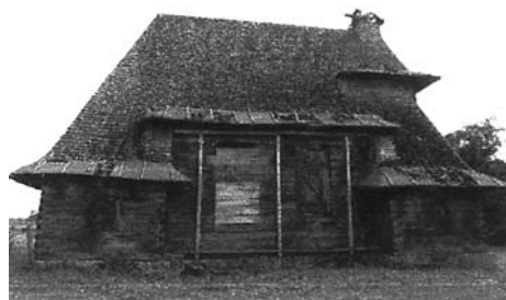
Kościółek przed rozbiórką
